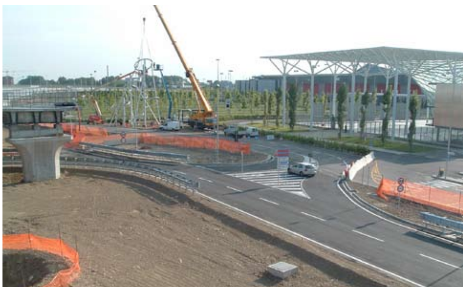
Lavori sulla rotonda ovale
