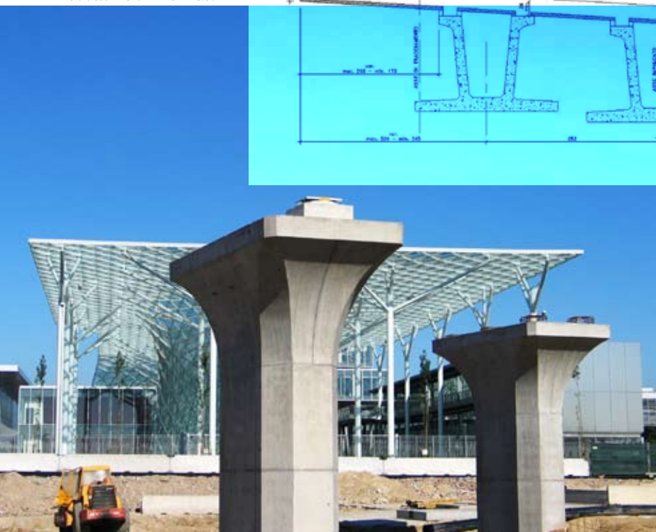
Viadotto Fiera - Pile in c.a.
