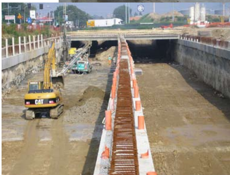
Galleria Cerchiello - Esecuzione cordoli diaframmi e posa travi di coperture in c.a.p.
