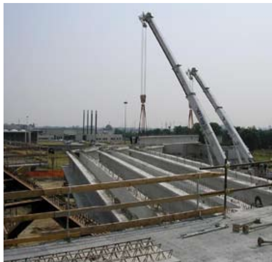
Opera 20 - Varo travi in c.a.p. su campata lato viadotto
