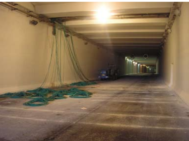
Installazione impianti illuminazione e sicurezza
