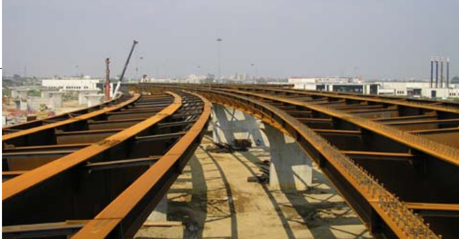
Viadotto Fiera - Varo impalcato in acciaio Carter
