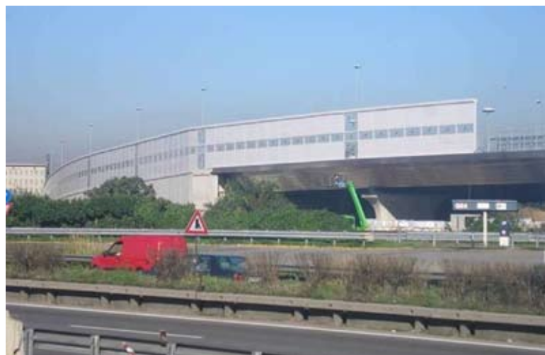
Barriere su viadotto
