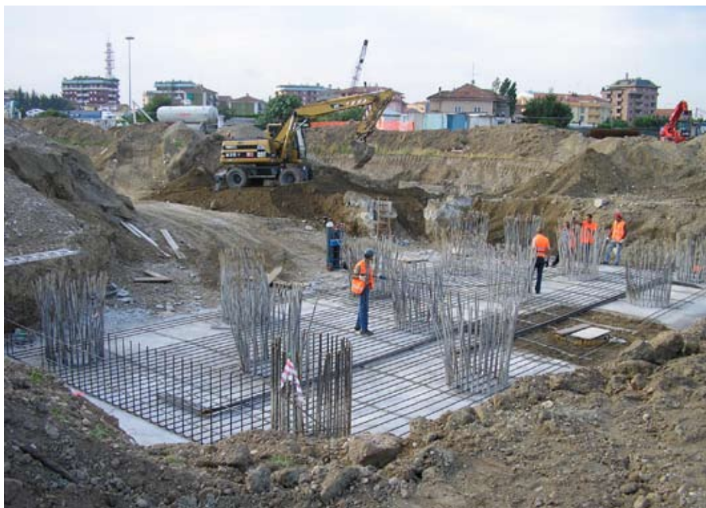
Viadotto Fiera - Esecuzione fondazione spalla Abis
