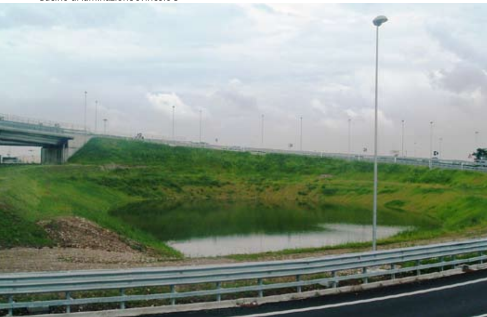
Bacino di laminazione svincolo 3
